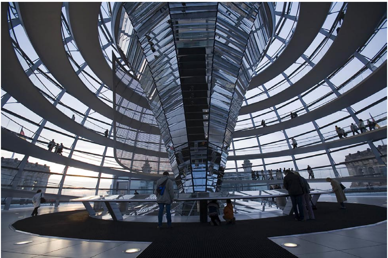
Rigsdagen i Berlin rummer en række tiltag, der sigter mod en bæredygtig udvikling. Et af de meget synlige tiltag er det store prisme, der forsyner salen med dagslys. Foto: Frederikke Friderichsen
