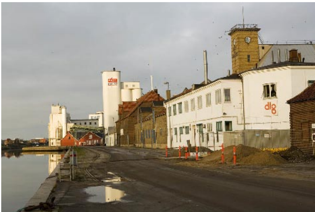
Bevaringsværdige ældre bygninger på havnearealerne Foto: Frederikke Friderichsen
