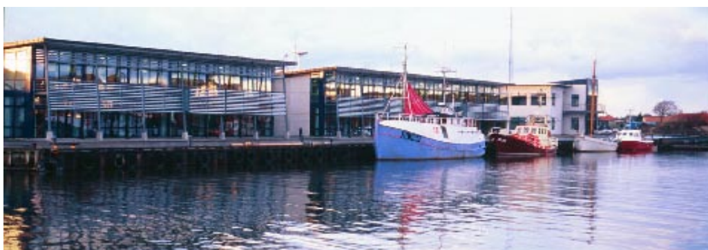
Vestas-arealet med kontorbygning som støjskærm Foto: Karsten Jørgensen
