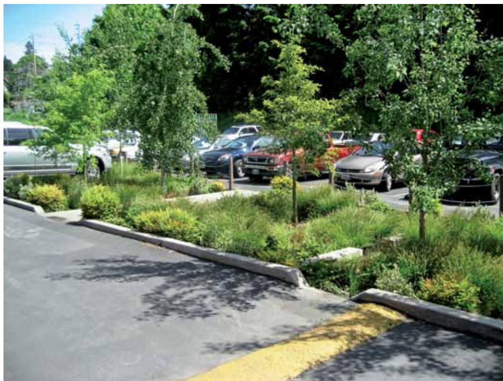
Figur 1: Eksempel på landskabsbaseret regnvandshåndtering. P-plads fra Portland, Oregon. Regnafstrømmingen nedsiver og fordamper i de vegetationsdækkede trug, der samtidig fungerer som æstetisk element på P-pladsen. I tilfælde af ekstremregn står vandet højt på P-pladsen, men forårsager ikke en belastning af hverken kloak eller omgivende by. Fotograf: Antje Backhaus.
