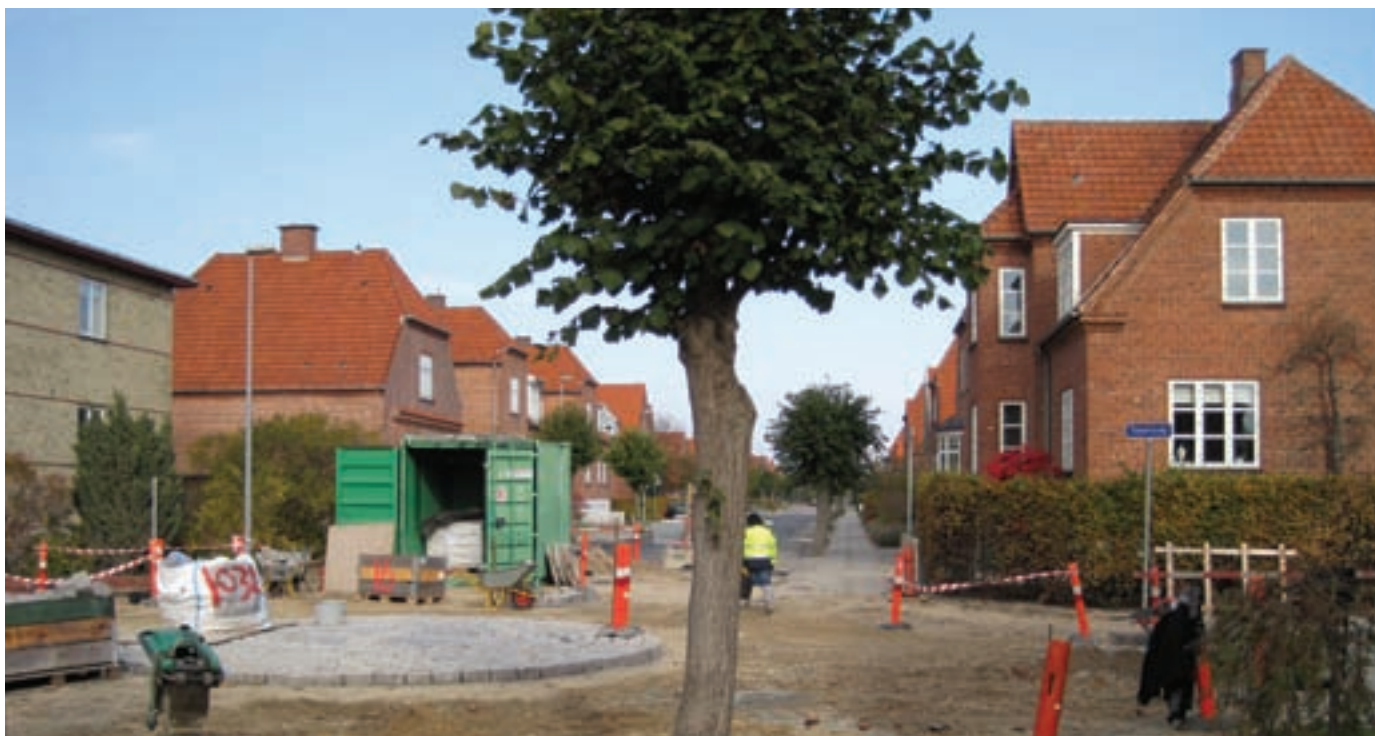
I villakvarteret omkring Pedersvej i Køge skulle kloakkerne renoveres, og vejen brydes op. Det resulterede i ny hastighedsdæmpning og forskønnelse af vejene. Foto: Niras
