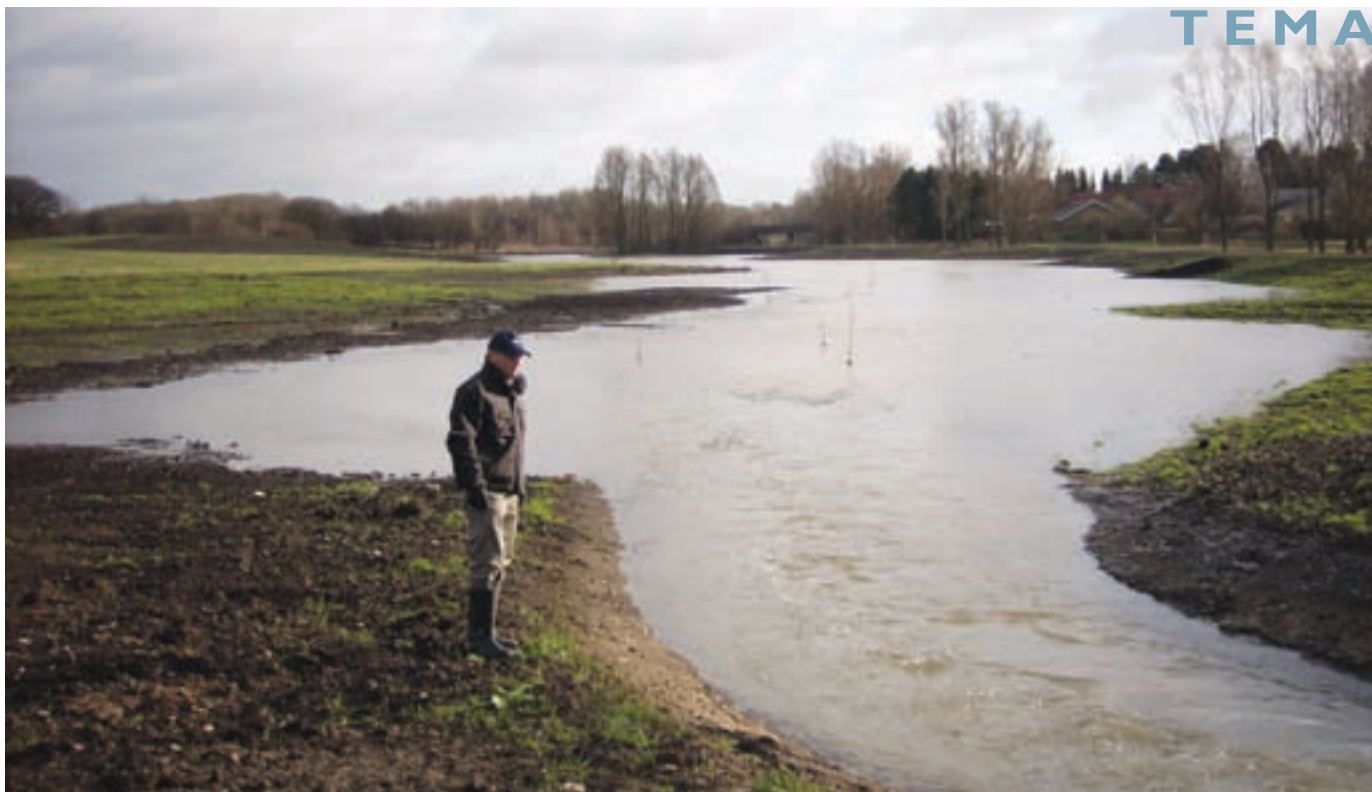
Dette slyngede vandløb er designet til, at kunne løbe over sine bredder ved kraftige regnskyl. De lave områder omkring vandløbet fungerer som et regnvandsbassin. Foto: Greve Kommune
