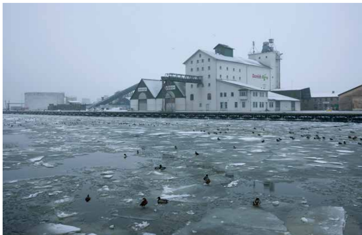
ØA-bygningen på en kold dag.
