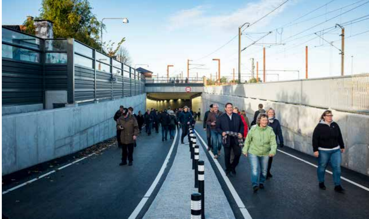
Så er der hul igennem! Fra åbningen af biltunnelen.
