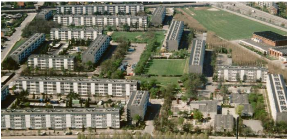
Ill. 6. 'Friheden med sine 1.170 boliger, hvor den stereotype bebyggelsesplan viser nogle ubensigtsmæssige bindinger dikteret af montagens kranspor og en udbredt mekanisk repetition.' (KAB 2008)
