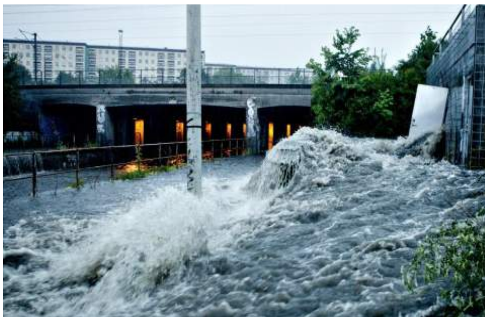
Oversvømminger ved Ryparken Station efter skybrud
