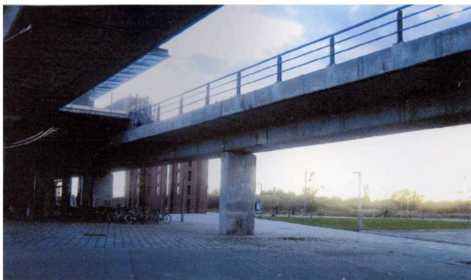
Fig. 7. DRs metrostation som nabo til Amager Fælled.
