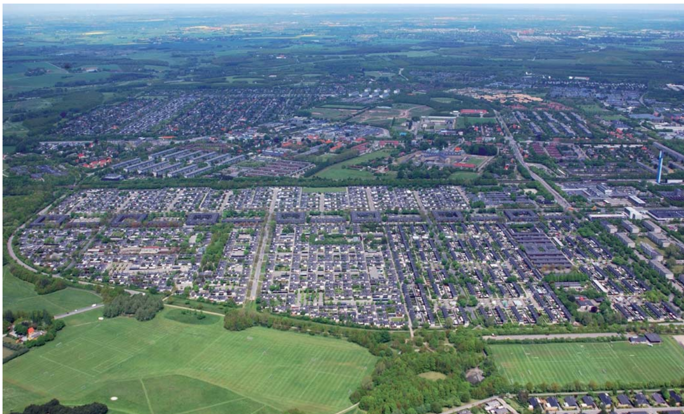
Luftfoto af Albertslund ca. 2010
