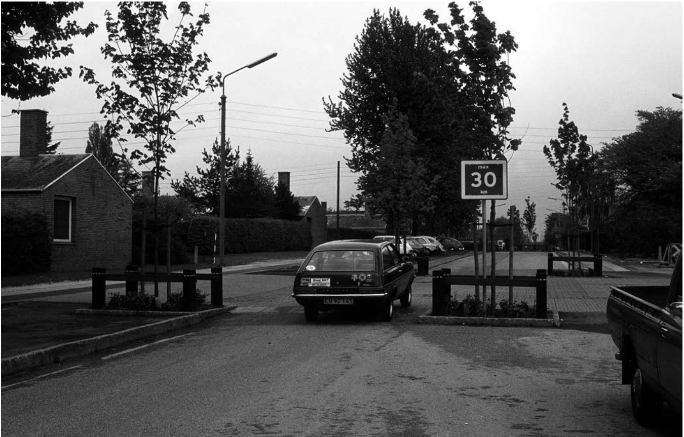
Rødovre, Fortvej. Trafiksanering i form af stillevej med hævet kørebaneplade og indsnævring.
