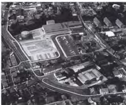
Sønderland i Holstebro. Holstebrohallen og boliger ved Storåen, anlægsarbejde for ringvej. Foto 1968.
