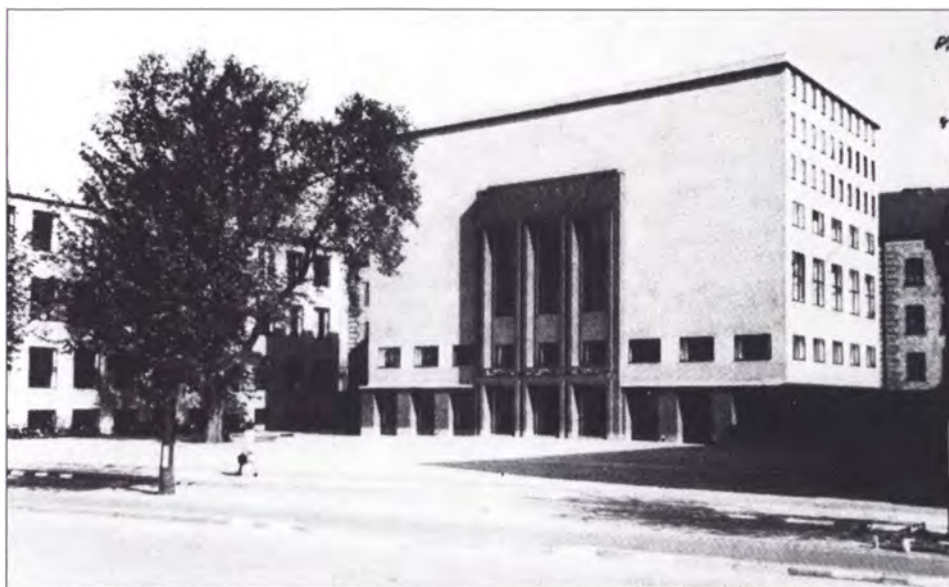
Den 'nye' Polytekniske Læreanstalt i Øster Voldgade.
