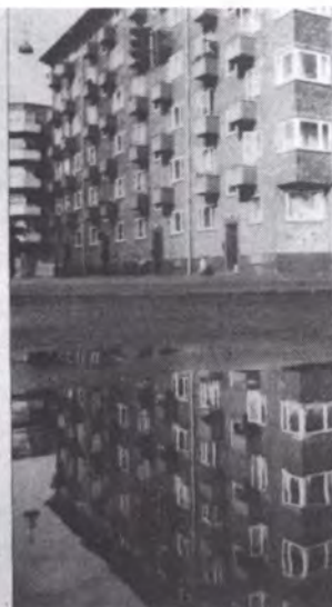
I denne ejendom på Østerbro er badevandet fra bad og håndvask genbruges til toiletter.
