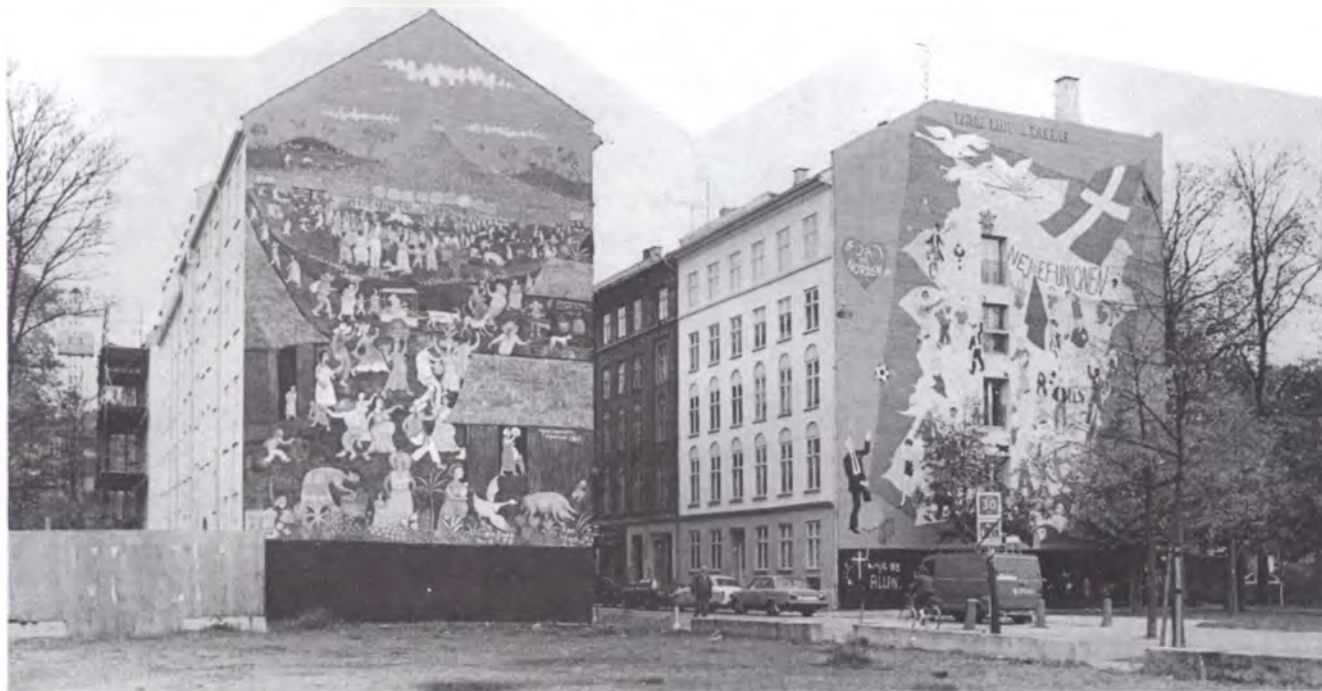
Murmaleri på to gavle i Dannebrogsgade udført i 1987.
