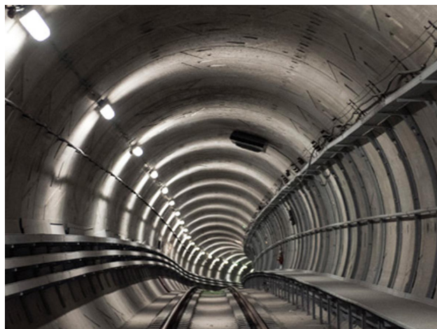
Metro-cityringen står færdig i 2019. Foto: Metroselskabet / René Strandbygaard
