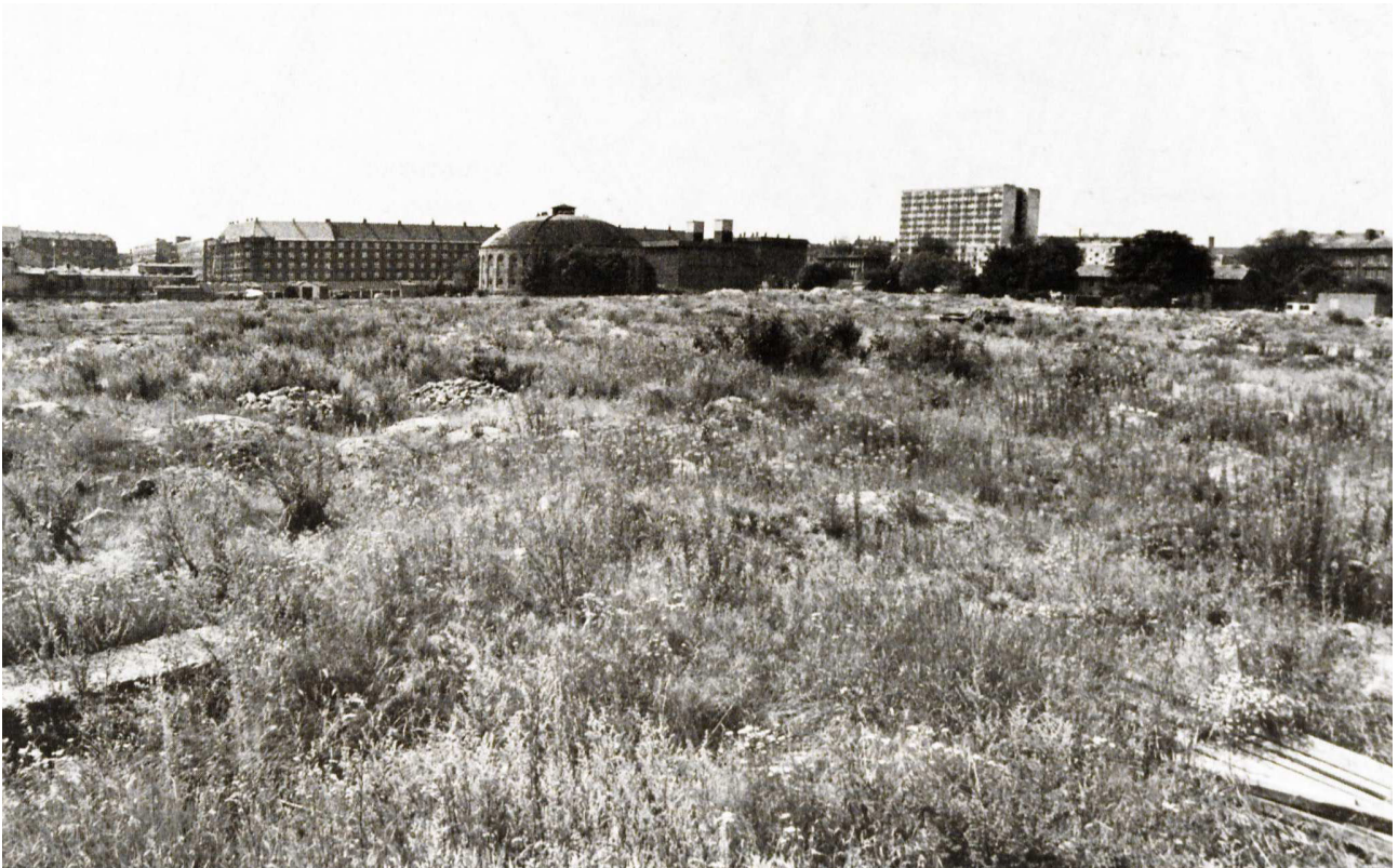
Østre Gasværks arealer efter nedrivning af gasværket. Kun en gammel gasbeholder, tegnet af arkitekt Martin Nyrop, stod tilbage. Grunden viste sig at være meget forurenset.
