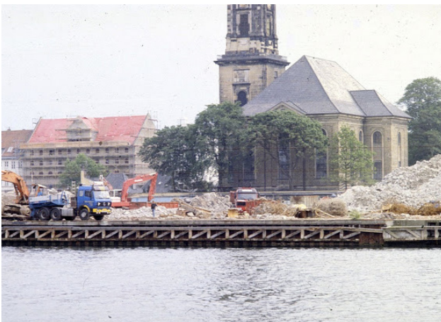
B &W under nedrivningerne. Foto: Karsten Jørgensen
