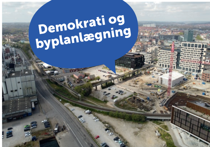
Luftfoto af udviklingsområdet Sydhavns-kvarteret i det centrale Aarhus
