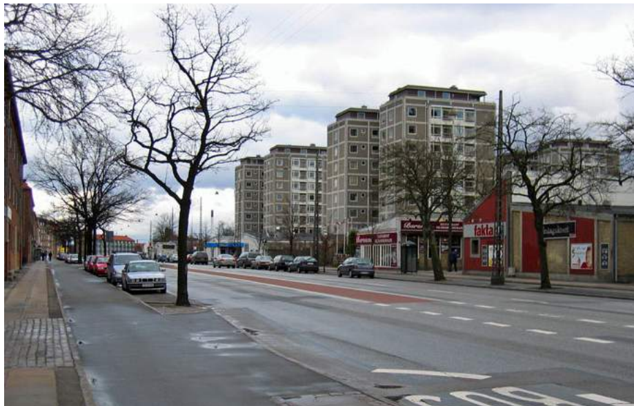
Bellahøjhusene (opført 1950-57) med tilhørende butikstorv set fra Frederikssundsvej. Foto: Thomas Bredøl.
